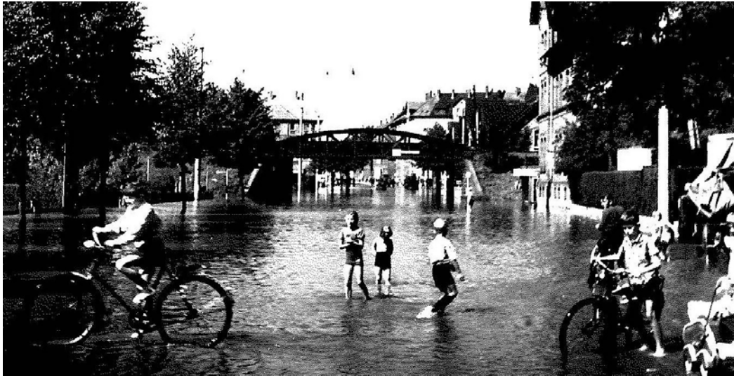
Abbildung 4-4: Hochwasser an Wabe/Mittelriede 1956 – Berliner Straße
